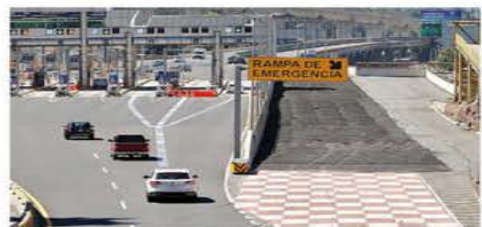
Una de las rampa de emergencia en la México-Toluca.
