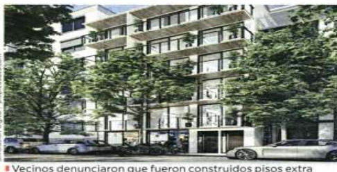
Vecinos denunciaron que fueron construidos pisos extra en Oaxaca 33 sin los permisos legales.
