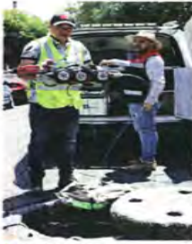
Personal aún realiza labores en el lugar.
