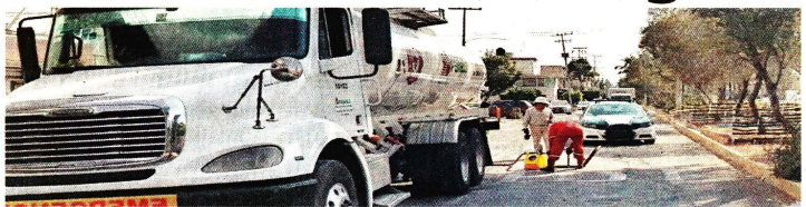
Cuadrillas de Pemex y de SGIRPC limpiaron colectores de desagüe en la zona.
