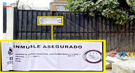
Una vivienda ubicada en la esquina de las calles 699 y 604, en Ciudad Lago, fue asegurada por una toma ilegal de combustible.
