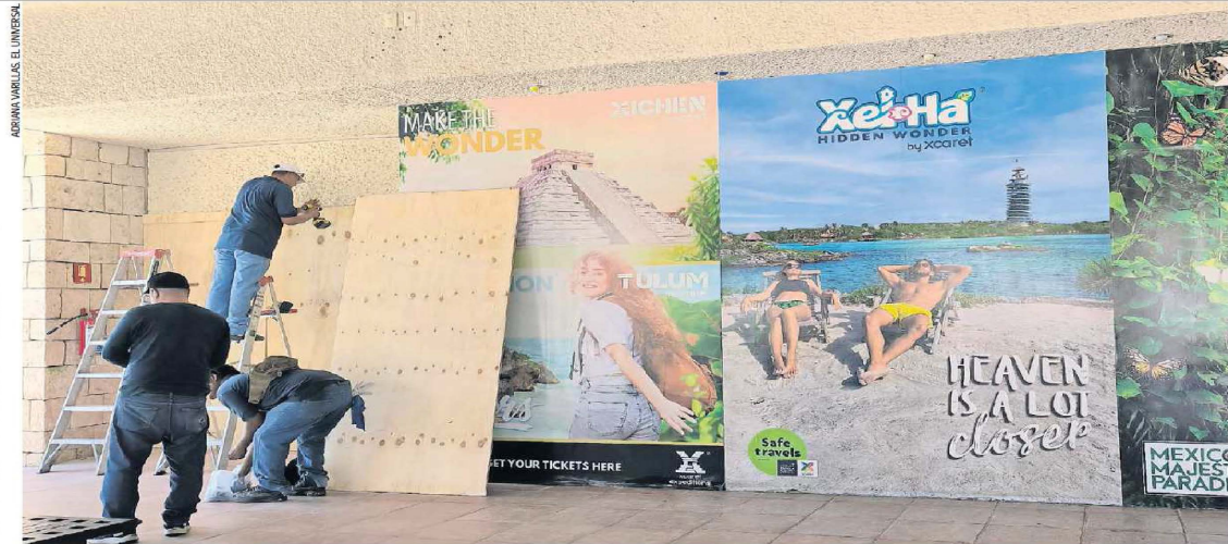
Trabajadores colocaban ayer tablas de protección en un embarcadero de Punta Cancún, en el corazón de la zona hotelera.
