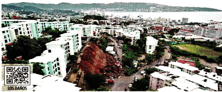
Edificios en Acapulco han quedado en riesgo de colapso, a causa de los deslaves.
