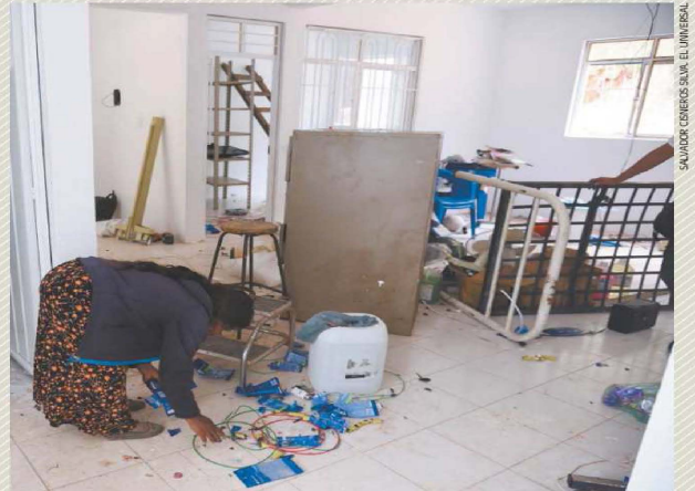
En Itia Zuti los pobladores rehabilitan la unidad médica e imploran por un médico.
