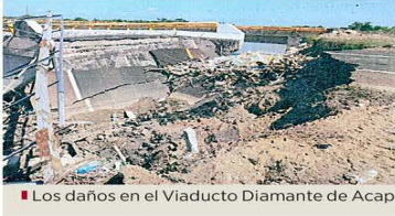
Los daños en el Viaducto Diamante de Acapulco han sido reparados provisionalmente.
