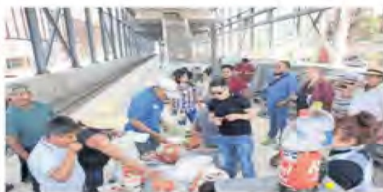
Luego de que los obreros se retiraron, los vecinos continúan e instalaron un campamento en lo que será la estación Teyahuacán.
