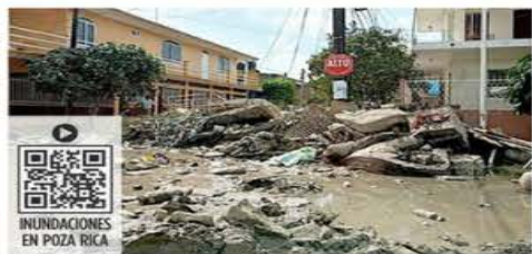
Lodo, muebles y basura permanecen en el sector La Quebradora, de la Colonia Morelos, en Poza Rica.
