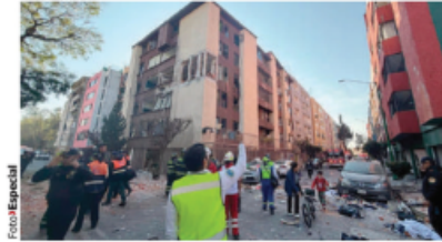
ASPECTO de los inmuebles afectados, ayer.
