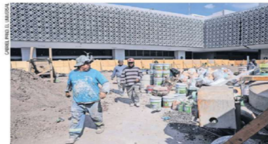
Por quinta ocasión se realizan trabajos de impermeabilización y cambio de piso en la explanada, debido a filtraciones.
