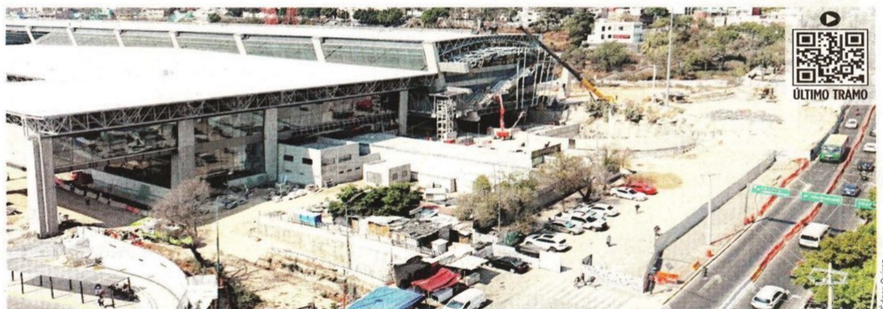
El acceso a la estación del Tren Interurbano desde la Avenida Sur 112, aún continuaba en obras el fin de semana.
